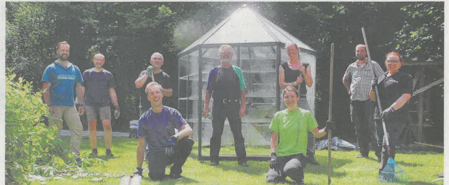
Haben gemeinsam angepackt, um eines der drei Gartenhäuschen im Sinnesgarten aufzustellen: Mitarbeiterinnen und Mitarbeiter der Norle sowie des Unternehmens Airbus in Bremen.
